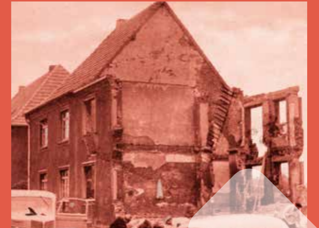
Durch die Angriffe während des Kriegs kam es zu schweren Schäden an den Häusern der GWG, auch an der Pulverstraße und am Kohlufer.
