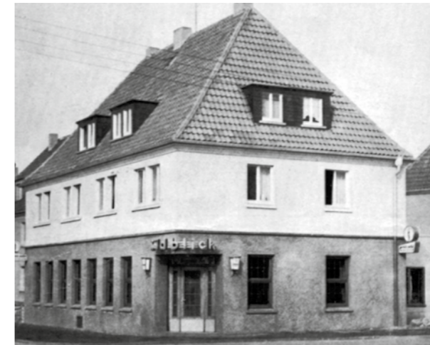
Eckhaus an der Lüttringhauser Str. / Am Hombruchsfeld: Im Krieg zerstört, wurde es später wiederaufgebaut; hier wurde die legendäre Gaststätte „Südblick“ eingerichtet.
