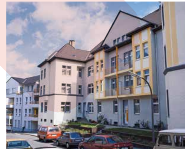
Blick auf die Eierkampstraße nach dem Abriss des alten Bestandes
