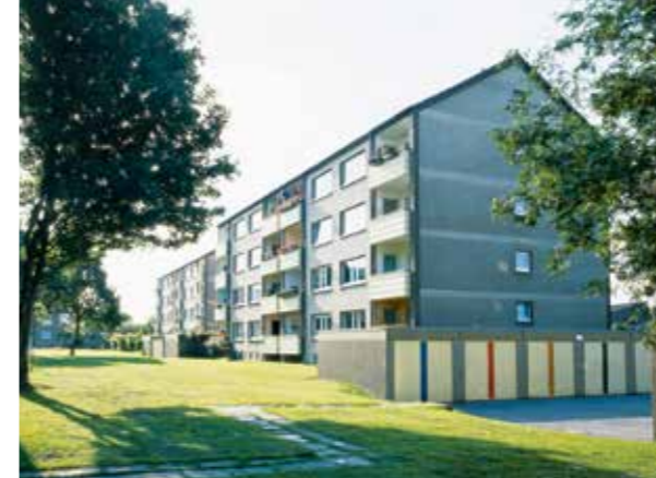
Das Haus Grotenkamp 10 in Persebeck gehört zum ersten Quartier, das die GWG außerhalb von Hombruch-Barop errichtete.
