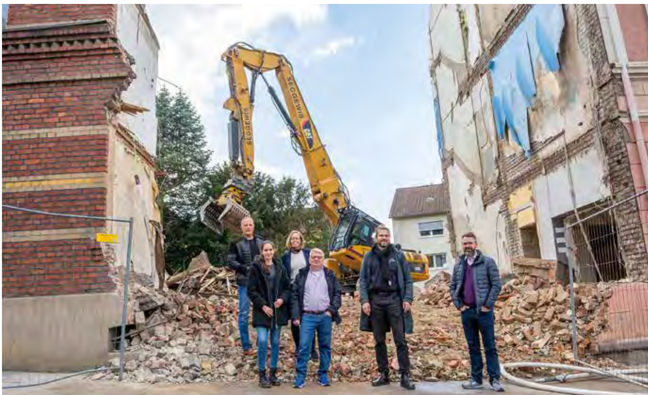
Der Beginn der Abbrucharbeiten
